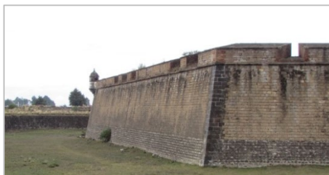
Fig. 7- Desde el foso seco se observa la disposición de los sillares de piedra basáltica y cantería de toba que conforman las caras y flancos de los baluartes, así como el uso de ladrillo en los parapetos del fuerte de San Carlos de Perote (Gladys Martínez, 2024).
