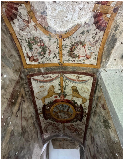
Fig. 5- Torre Guevara, particolare degli affreschi all'intradosso delle volte della scala (foto di Raffaele Amore, Francesca Capano, 2024).
