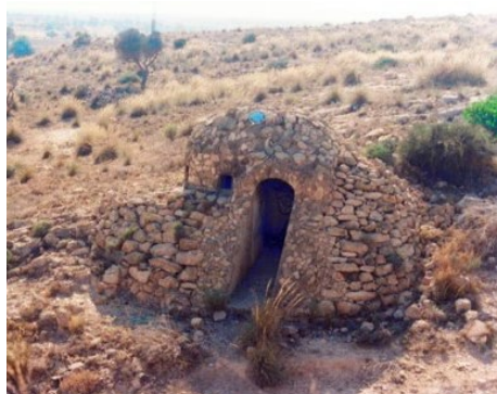
Fig. 17- Casamata camuflada con piedras del terreno, Arenales del Sol, España (autor 2004).
