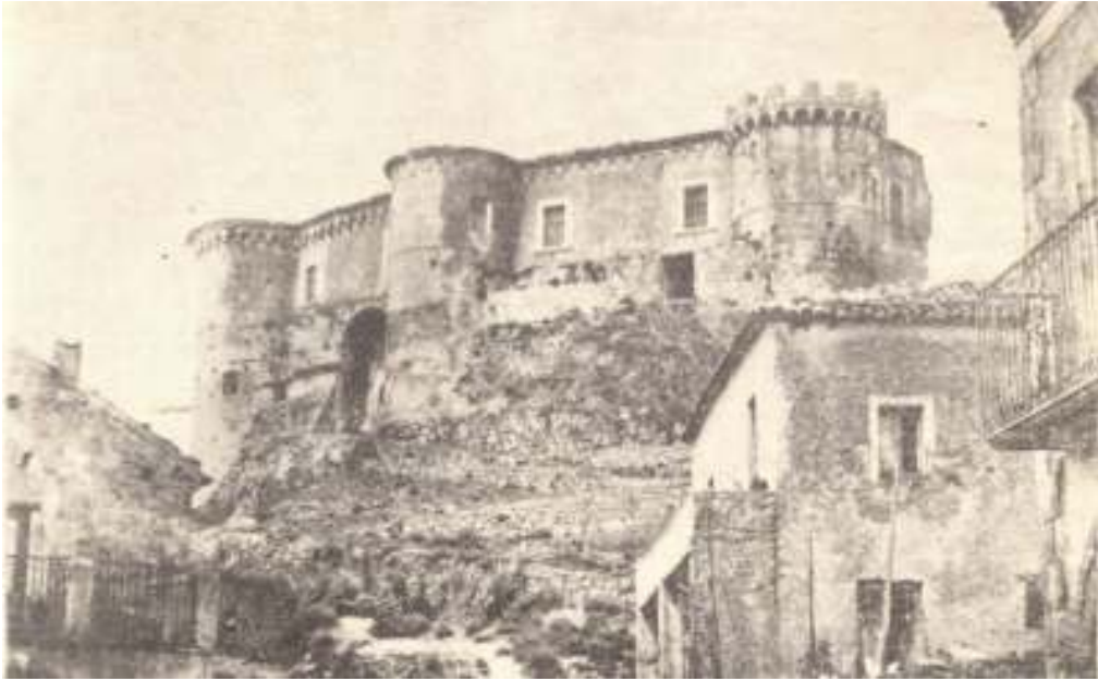
Fig. 5- Il castello di Rocca Cilento prima dei recenti interventi di ristrutturazione, Archivio Natella.
