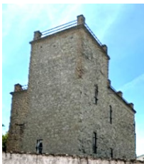
Fig. 7- Fotografía de la esquina noreste del edificio torreado situado en la Calle Maestra, 50 de Escañuela (Luis José García-Pulido, 2024).
