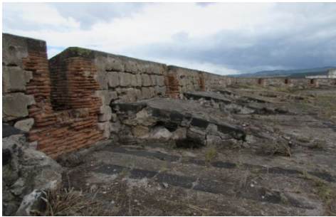
Fig. 9- Combinación de materiales en parapeto y terraplenado de baluartes en el fuerte de San Carlos de Perote (G. Martínez, 2020).
