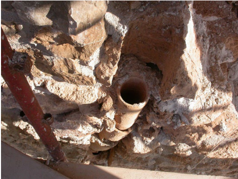
Fig. 1- Alghero, Torre del Bollo, pluviale di alimentazione della cisterna (Billeci, 2006).
