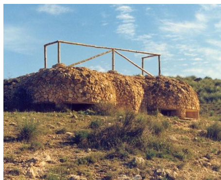
Fig. 18- Búnker mimetizado con piedras del entorno, Clot de Galvany, España (autor 2004).
