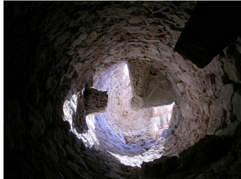
Fig. 2- Alghero, Torre di Tamariglio, scala di accesso alla terrazza in elementi squadrati (Billeci, 2004).
