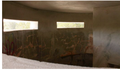
Fig. 15- Interior de un búnker con aspilleras horizontales en el cabo de Santa Pola, ca. 1937-1938, España (autor 2015).
