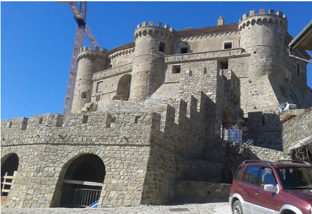
Fig. 6- Il castello di Rocca Cilento dopo gli interventi di ristrutturazione.
