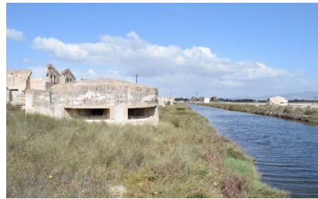
Fig. 21- Búnker junto al canal del Parque de Monlentargius, Cagliari, Italia (autor 2020).
