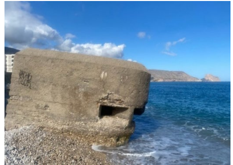
Fig. 9- Búnker de hormigón en la playa de Altea, ca. 1937-1938, España (autor 2019).
