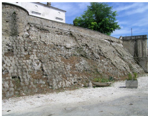
Fig. 6- Il muraglione del Castello Baronale di Acerra prima degli interventi di restauro (Paolo Giordano, 2003).
