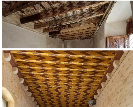
Fig. 6- Arriba : Forjado de madera sin restaurar en el piso superior. Abajo: Forjado de madera restaurado en el ala oeste de la planta noble (Concepción López, 2024).
