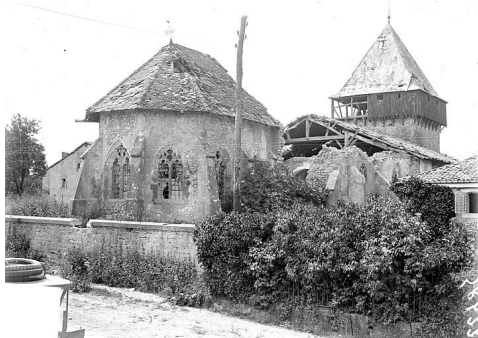
Fig. 1- Eglise de Saint Gorgon, Woël (dipartimento della Mosa, Francia), Vista Nord-Est dell’edificio danneggiato durante la I Guerra Mondiale, 1914-1919ca (©Ministère de la Culture, France, Médiathèque du patrimoine et de la photographie, diffusion GrandPalaisRmn Photo).
