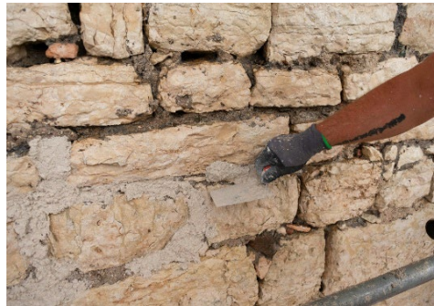
Fig. 8- Fase di applicazione della malta di ripristino (M. Mazzocchi, 2023).
