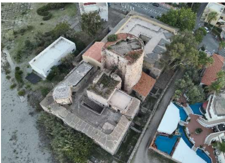
Fig. 11- Il forte degli inglesi visto da nord. Si noti la rifasciatura tondeggiante in muratura mista listata dell'originaria torre a base quadrata possibile rilevare anche dall'osservazione della
