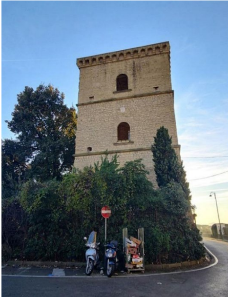
Fig. 2- Nápoles. Casa-Torre Ranieri en la colina de Posillipo Foto de Marco Ceci, 2024).
