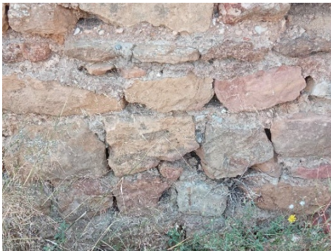
Fig. 16- Piedra ligeramente labrada. Tráves del bastión sureste (Fotografía del autor, 2024).
