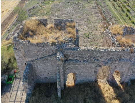
Fig. 7- Vista dall'alto delle tracce in negativo del solaio piano del vano centrale e del solaio a spiovente dell'ampliamento laterale (foto dell'autrice, 2024).
