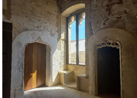
Fig. 11- A la izquierda de la imagen puerta de paso adornada con baquetón y arco conopial. A la derecha se observa el arco conopial con tracería calada. Entre ambas se encuentra la ventana aljimezada con «festejador» (Concepción López, 2024).
