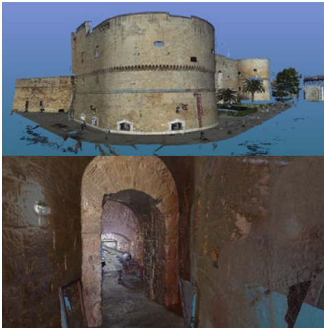
Fig. 5- Vistas de la nube de puntos densa del Castello Aragonese di Taranto (Elaboración gráfica de los Autores, 2024).
