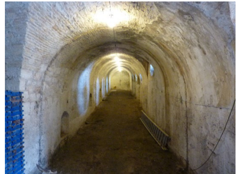
Fig. 3 -Galleria di sortita, bastione Raimondo, Corfù (foto di Dragos Cosmescu, 2024).
