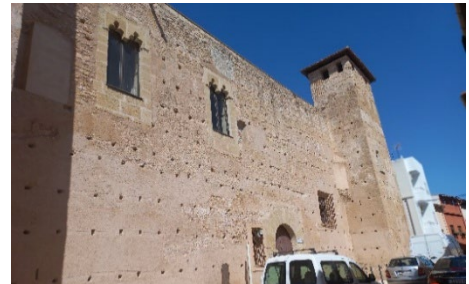
Fig. 4- Fachada sur de acceso al Castillo-Palacio (Concepción López, 2024).
