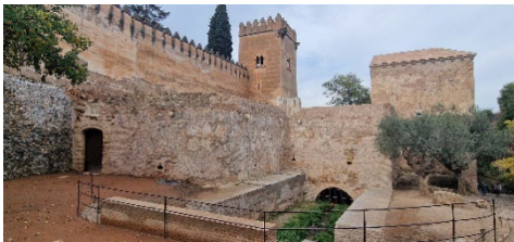
Fig. 8- Vista del exterior después de las obras (A. Orihuela).
