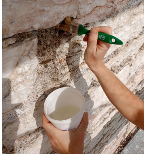
Fig. 7- Consolidamento della malta originale (M. Mazzocchi, 2023)
