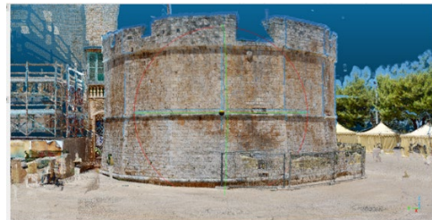
Fig. 4- Vista de la maya texturizada de la torre poligonale del Castello Aragonese Aquaviva en Conversano (Elaboration grafica de los Autores, 2024).
