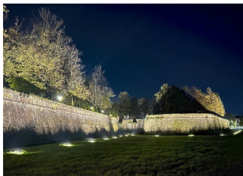
Fig. 2- Cortina e baluardo San Paolino nel tratto occidentale delle mura di Lucca (foto degli autori, 2024).
