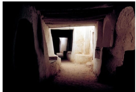
Fig. 11- Ghadames: strada coperta illuminata da pozzis-luce (foto dell'autore, 2024).
