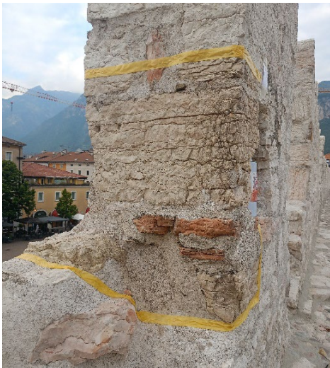
Fig. 10- Prova per idrorepellente (M. Mazzocchi, 2023).
