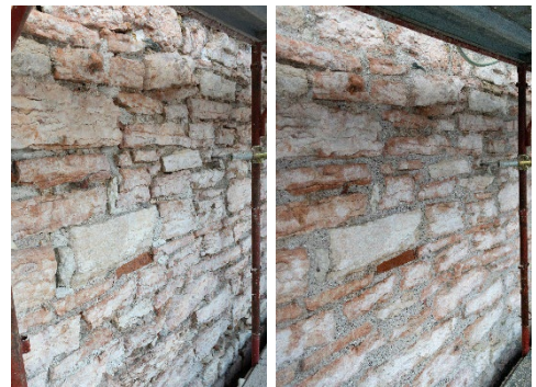
Fig. 11- Porzione di muratura prima e dopo l'intervento di restauro (M. Mazzocchi, 2023).
