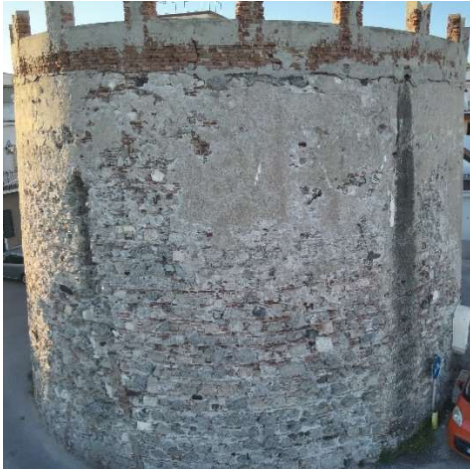
Fig. 7- La Torre Cariddi di Ganzirri vista da est. Si noti la muratura mista, listata con elementi laterizi di piccole dimensioni intervallate a puddinghe e conci di pietra calcarea.
