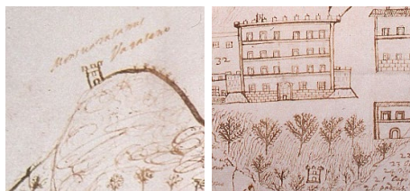
Fig. 5- La torre sul colle Guarassano (a sinistra) e sul colle Triglio (a destra) nella veduta della Biblioteca Angelica (Roma, Biblioteca Angelica, Bancone Stampe, BSNS 56/56).
