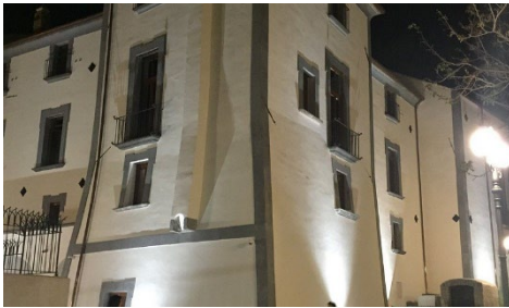
Fig. 2 The Nord-Est corner (post-restoration) (Luciana Di Gennaro, 2016).
