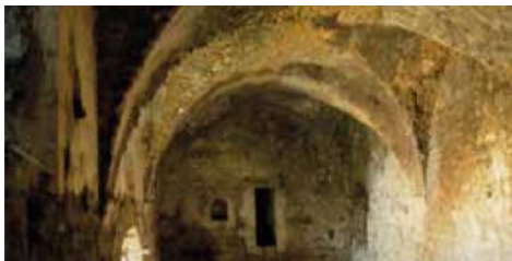
Fig. 6- Veduta delle volte a crociera presenti nella torre orientale.
