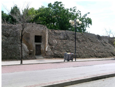
Fig. 8- L'accesso al Castello Baronale di Acerra prima degli interventi di restauro (Paolo Giordano, 2003).
