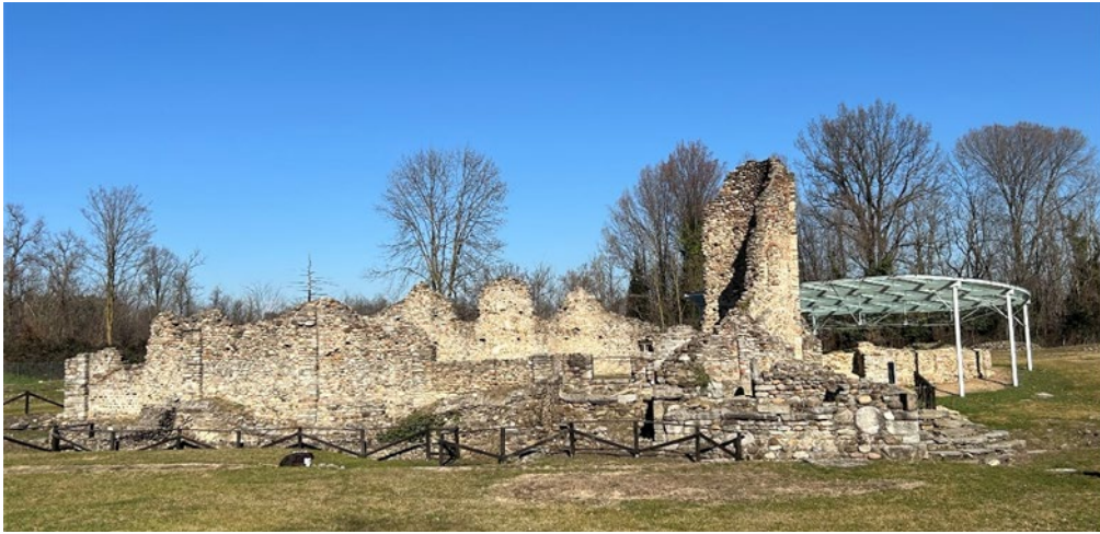
Fig. 6- Il complesso di San Giovanni. (Giorgia Gentilini, 2024).
