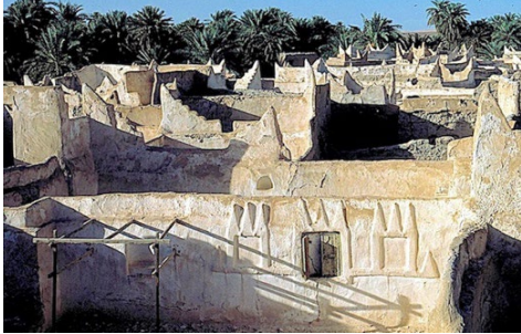
Fig. 14- Ghadames: skyline dell'abitato con i serafin all'angolo degli edifici (foto dell'autore, 2004).
