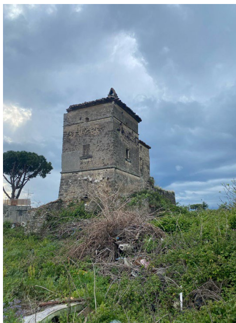
Fig. 9- Sessa Aurunca (CE). Casa-Torre en la Finca della Signora (Foto de Marco Ceci, 2024).
