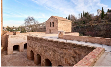
Fig. 7- Vista general interior después de las obras (J.M. Díaz Rubio, Masoel Fotopro).
