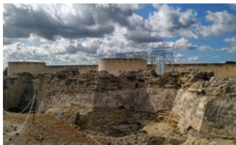
Fig. 5- Vista general del frente oriental de la falsabraga (Autores, 2024).
