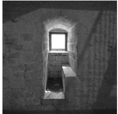
Fig. 4- Una delle postazioni di tiro/osservazione. Si può notare come attualmente siano presenti delle finestre quadrangolari mentre un tempo queste aperture dovevano probabilmente essere costituite da feritoie (foto dell'autore, 2024).
