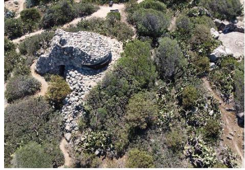
Fig. 5- Bunker, con feritoia orizzontale edificato con le sembianze di un nuraghe (foto di N. Paba, 2024).
