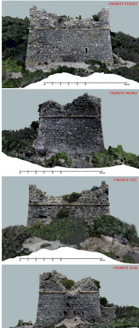
Fig. 3- Ortoimmagini dei prospetti della Torre di Calamoresca tratti dal modello mesh elaborato sulla base della ricostruzione SfM (elaborazioni di F. Lanfranchi, 2024).
