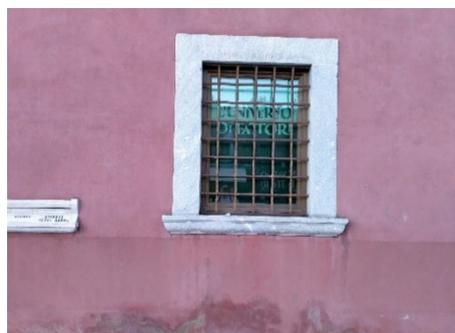
Fig. 6- Intonaco cementizio nella fascia bassa dell'edificio e fenomeni di degrado correlati (A. Di Paola, 2022).
