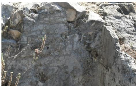
Fig. 7- Lacerti di intonaco superstiti in corrispondenza di una porzione muraria recentemente dissotterrata (foto dell'autore, 2024).
