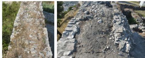
Fig. 9- Copertine murarie non protette a diverso livello di disgregazione delle malte con perdita dei sacchi murari (foto dell'autore, 2024).
