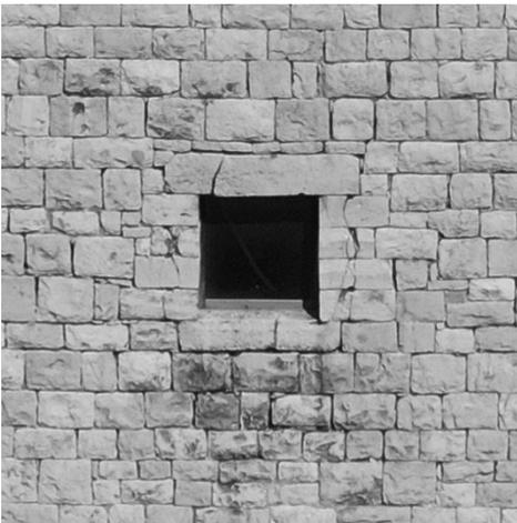
Fig. 5- La stessa apertura vista nella Fig. 4 ora vista dall'esterno. Sono evidenti le manipolazioni della muratura circostante l'apertura (foto dell'autore, 2024).
