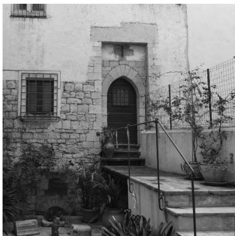
Fig. 7- Una foto della *posterula* dove si possono osservare tutti gli elementi che ne spiegano il funzionamento. Si può inoltre notare come sia ben ammassata alla muratura attorno, questo ci consente di collocarle in uno stesso frangente temporale (foto dell'autore, 2024).
