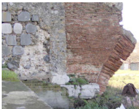
Fig. 4- Castel Volturno (Ce), castello, fronte est, dettaglio dell'arcata romana con cortina laterizia e del paramento longobardo in 'basoli' lavici di recupero (Guerriero, 2006)
