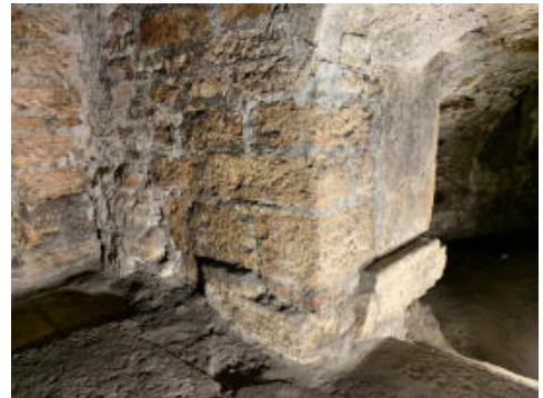
Fig. 5- Vista sacco muratura M64 in angolo (foto dell'autore)
