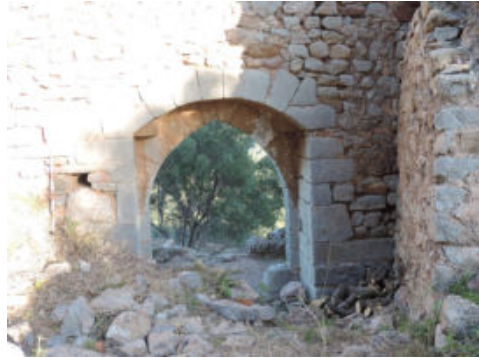
Fig. 6- Vista del interior de la puerta de acceso a la alcazaba (foto por Jaime Prior, 2018)
