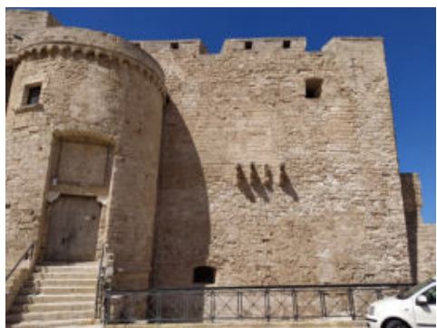
Fig. 7- Monopoli, Castello Carlo V. Prospetto Sud-Ovest (foto di Piernicola Cosimo Intini, 2020)
