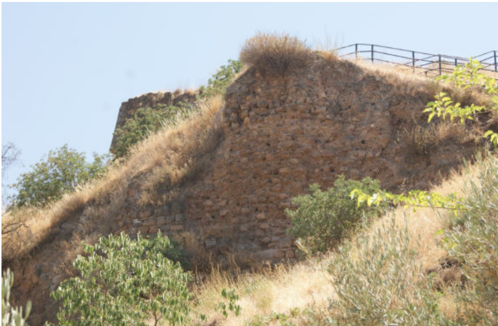
Fig. 6- Torre y muralla realizada en mampostería concertada con hiladas de ripios en el castillo de Cambil (R. Modrego Fernández)
