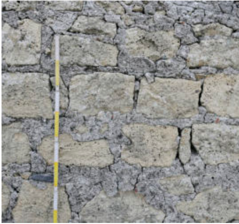
Fig. 6- Castel Volturmo (Ce), castello, fronte ovest, dettaglio della muratura altomedievale realizzata con blocchi di tufo giallo di recupero, danneggiati dal prelievo dal sito di prima giacitura (Guerriero, 2006)
