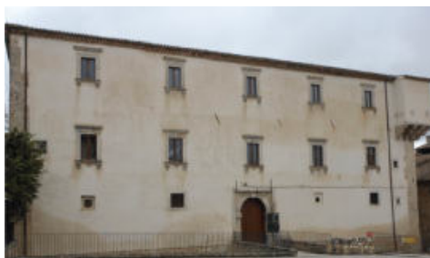
Fig. 12- Palazzo Santucci. Facciata principale nord-ovest
