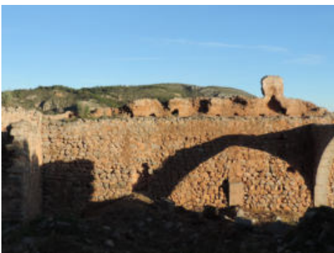
Fig. 7- Tramo oriental de la muralla norte del recinte jussà . Restos del almenado de tapia (foto por Jaime Prior, 2018)
