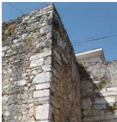
Fig. 8- Una delle torri presso le porte della cinta muraria dopo i recenti interventi di restauro (Romeo, 2021)
