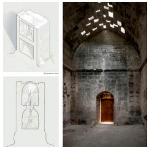
Fig. 9- En interior de la torre tras la restauración con la entrada de luz cenital por la bóveda superior reintegrada con sillares de piedra y de vidrio (Vegas & Mileto, 2020)
