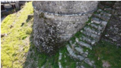
Fig. 10- Parte basamentale del torrione circolare visto da nord, foto da drone (foto di Andrea Calcagnini, 2021)
