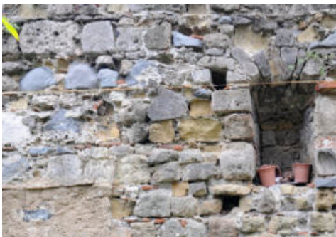
Fig. 8- Castel Volturmo (Ce), castello, corte bassa, fronte est, dettaglio del paramento protomoderno a ricorsi orizzontali periodici (a 'cantiere') (Guerriero, 2006)
