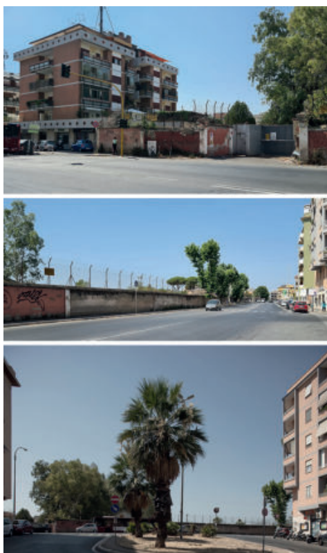
Fig. 6- Il muro di recinzione dell'area militare intorno al Forte Boccea, fotografato da Via di Boccea e da Largo Gregorio XIII (foto degli autori)
