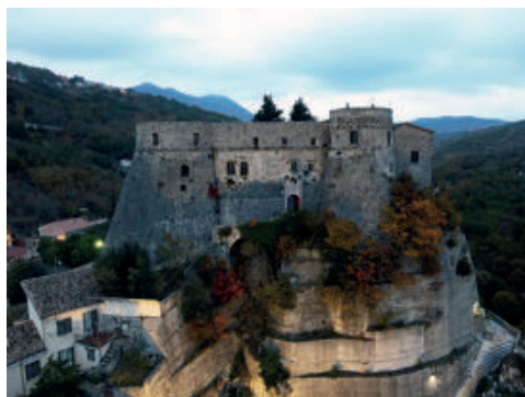
Fig. 3- Cerro al Volturno, Castello Pandone, vista aerea del maniero da sud, in primo piano il fronte sudoccidentale del castello con il portale d'accesso tra le torri ovest e sud, in basso a destra è visibile l'intervento di consolidamento statico in calcestruzzo realizzato nel XX secolo (foto di Alberto Chiaiese, 2021)
