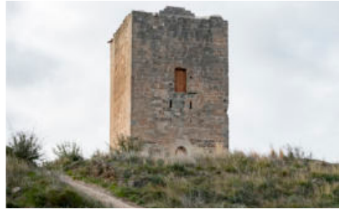
Fig. 11- La fachada principal de la torre tras de la restauración (Vegas y Mileto, 2020)
