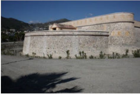
Fig. 7- Fuerte de La Herradura, con recuperación de la altura original de la batería y reconstrucción del tinglado de la artillería (foto por Antonio Orihuela, 2011)
