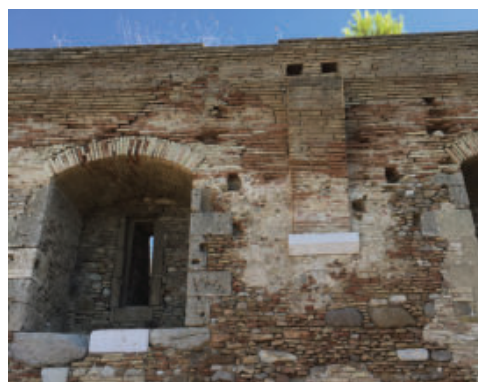
Fig. 5- Particolare del paramento lungo la galleria interna (foto di Enrico Carafa, 2021)
