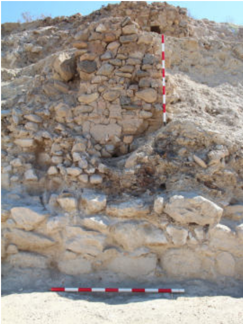
Fig. 5- Zócalo de mampostería de la muralla y restos de la reparación de la tercera fase constructiva (foto por Pablo Romero Pellitero)
