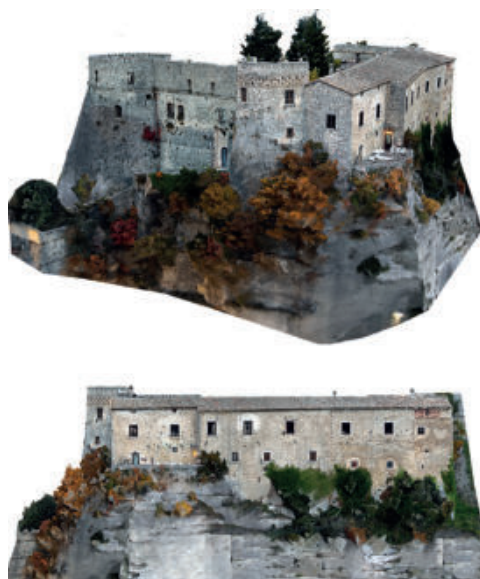
Fig. 6- Cerro al Volturmo, Castello Pandone, ricostruzione digitale del maniero, in alto modello tridimensionale texturizzato in vista prospettica da sud, in basso ortomosaico del fronte sud est. (D. Crispino, 2022)
