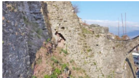
Fig. 12- Lesioni e mancanze nel lato sud, foto da drone (foto di Andrea Calcagnini, 2021)
