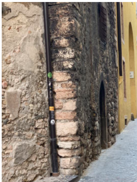
Fig. 6- Vista nord-ovest angolata M10 (foto dell'autore)
