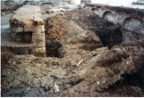
Fig. 7- Il fortino nella condizione precedente le operazioni di scavo, 1988 (ASABAPNa, b. 4/373, n. 48437 F)
