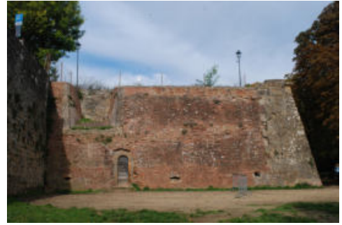
Fig. 2- Veduta del fianco sud-est del Bastione (foto di Roberto Castiglia)
