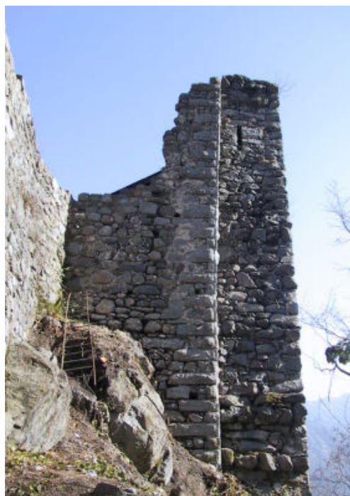
Fig. 3- Prospetto ovest della torre scudata con addossamento delle murature di potenziamento difensivo del XIV secolo – fase II (foto di M. Rodoani)
