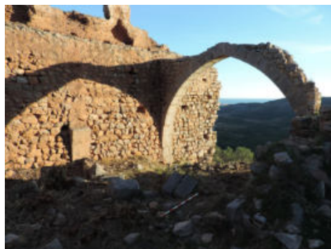
Fig. 8- Sala con arquería gótica completa. Se observan los arranques del arco paralelo cuyas dovelas reposan entre los escombros situados en el interior del recinto (foto por Jaime Prior, 2018)
