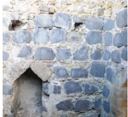
Fig. 7- Castel Volturmo (Ce), borgo di S. Castrese, saliente meridionale, interno, dettaglio della muratura longobarda in 'basoli' di lava leucitica del Roccamonfina, prelevati dal lastrico della Domiziana (Guerriero, 2006)
