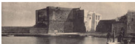
Fig. 5- Monopoli, Castello Carlo V. Prospetto Nord- Ovest, immagine precedente gli anni '50 del Novecento. Si distinguono lo sperone a punta di diamante, non ancora abbattuto e, attraverso il varco nelle mura cittadine, non ancora ricucite, le arcate accanto al torrione cilindrico, sulla parte di alzato che guarda la città (Archivio Storico Soprintendenza A.B.A.P. per la città metropolitana di Bari, b. Monopoli, Castello Carlo V, 1940?)
