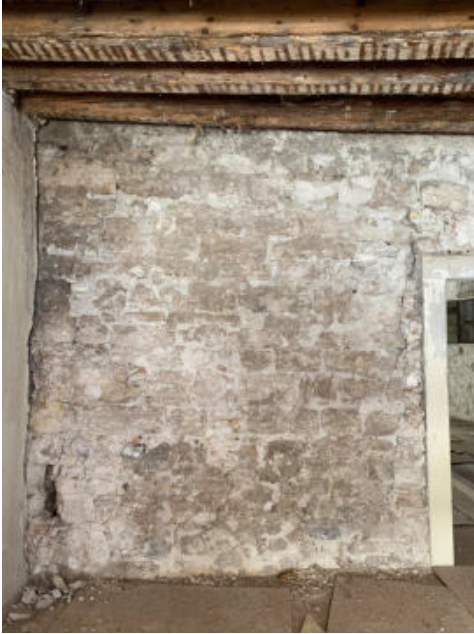
Fig. 11 - Prospetto esterno nord, livello 2 (foto dell'autore)
