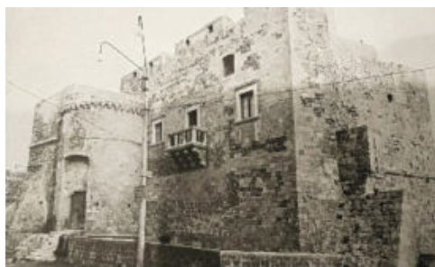
Fig. 6- Monopoli, Castello Carlo V. Prospetto sud-ovest. Si distinguono le finestre con cornici sottodavanzale e il balcone con mensole (Barletta, M., Papio, A. & Rotondo, S., 1992: p. 89)
