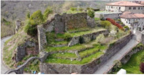
Fig. 8- Vista da Est, foto da drone (foto di Andrea Calcagnini, 2021)
