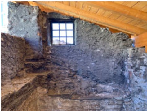
Fig. 13 - Risega muraria e sopraelevazione (foto dell'autore)
