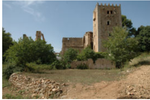
Fig. 2- Fachada sur de la Iglesia y Torre de la Murta (l.a., 2005)
