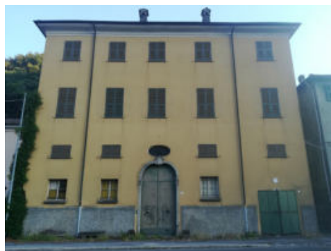
Fig. 5- Palazzo Spinola di Pietrabissara, fronte su strada (foto di Paolo Granara, 2022)
