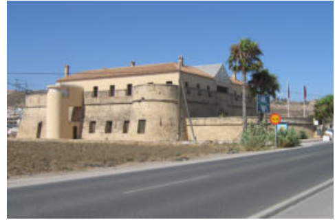
Fig. 8- Fuerte de Valleniza, renovado para albergar una Escuela de Hostelería (foto por Antonio Orihuela, 2007)
