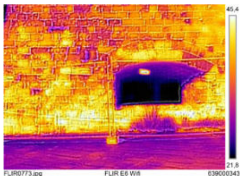
Fig. 9- Monopoli, Castello Carlo V. Prospetto sud-ovest, indagine termografica (elaborazione grafica di CFEngineering, 2020)
